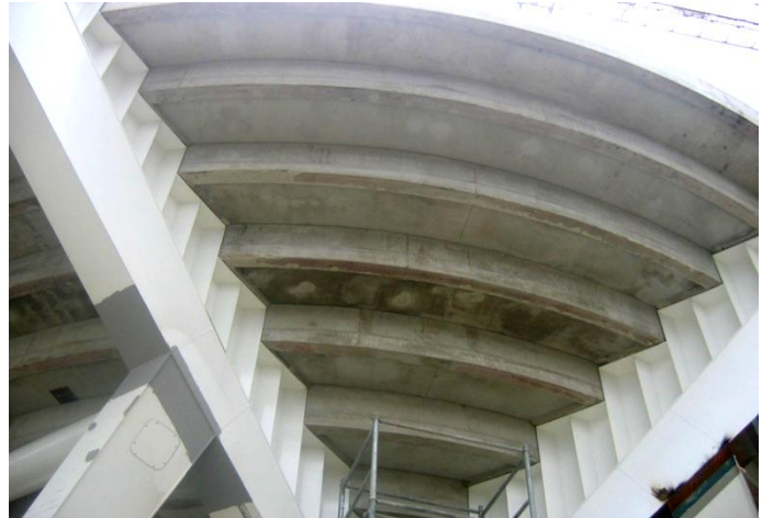
Vue de dessous : gradins
