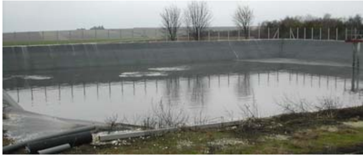
Bassin de stockage
